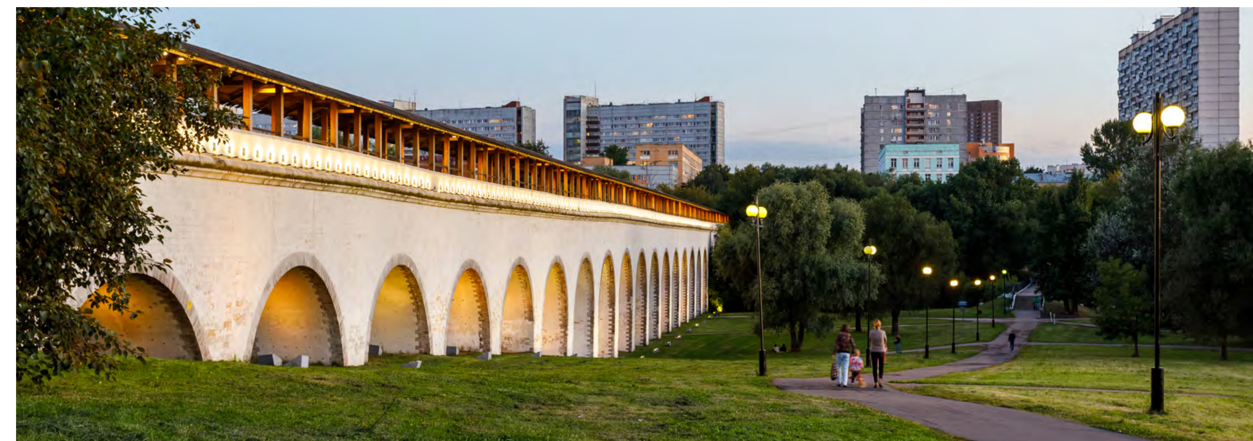
Ростокинский акведук, воздвигнутый во времена Екатерины II, в настоящий момент — самый старый по годам постройки мост Москвы: он не перестраивался с 1804 года. Акведук окружен уютным городским парком.
